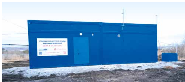
Рис. 5. Блочно-модульная станция водоочистки «Свободный». Три технологические линии мощностью 40 м 3 /ч объединены в комплекс с единой системой управления мощностью 120 м 3 /ч
