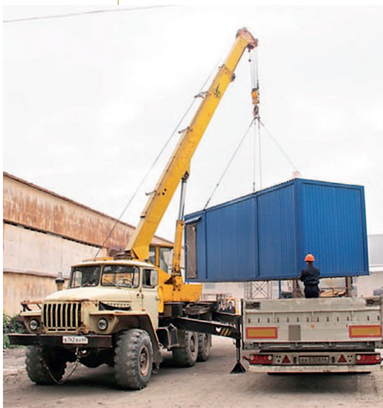
Погрузка блока станции на трейлер
