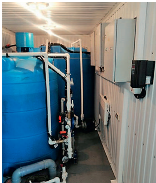
Технологическое оборудование блока станции очистки воды
